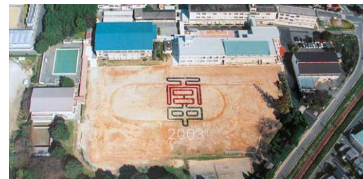
新南校舎完成(H15)
