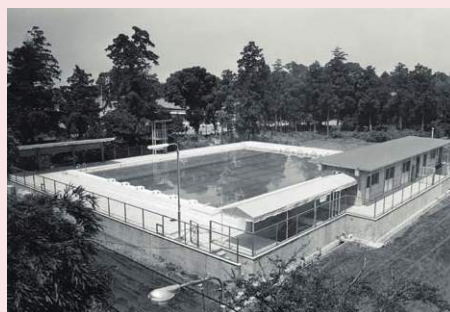
プール竣工(S50)
