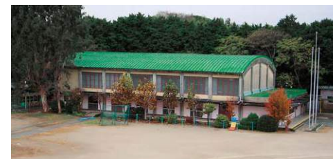
旧体育館(S43竣工)
