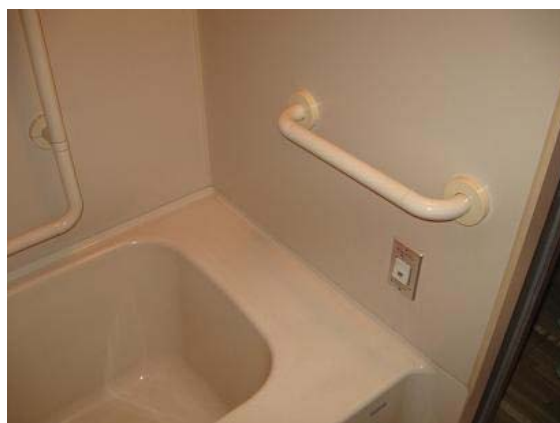
シルバーハウジング（浴室内の手すり・緊急通報システムのボタン）
