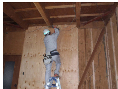
耐震改修の様子
