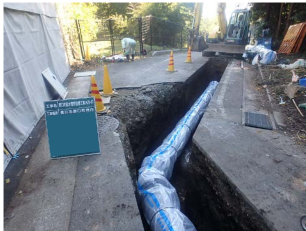
長寿命管の布設状況
