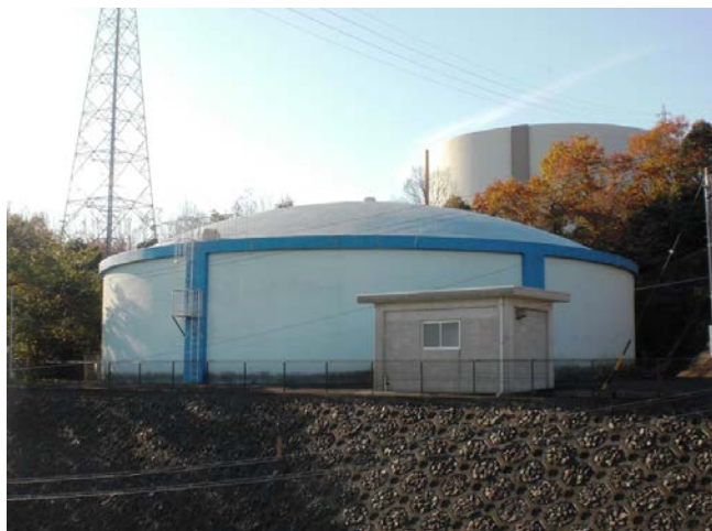
平尾第1配水池
