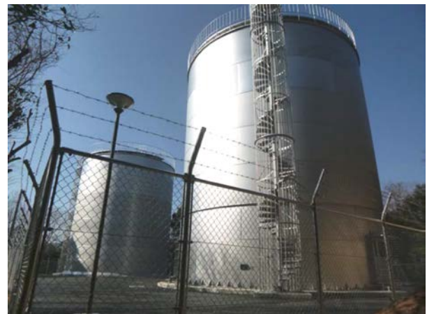
更新した中山配水池
