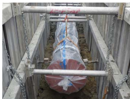
基幹管路の耐震化工事の様子
