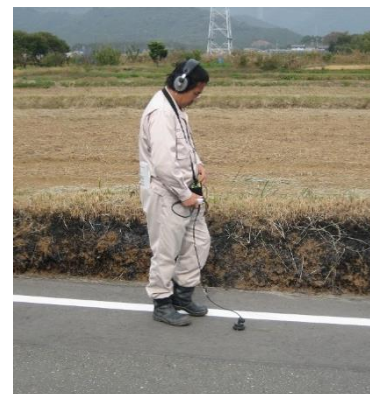
写真 3. 水道維持管理作業員 (漏水調査)
