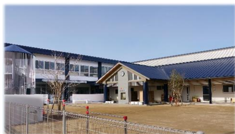
桜町保育園【建替え・大規模改修】
