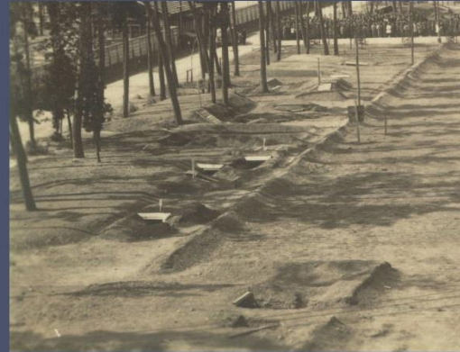
光学部事務所付近に設けられた防空壕
