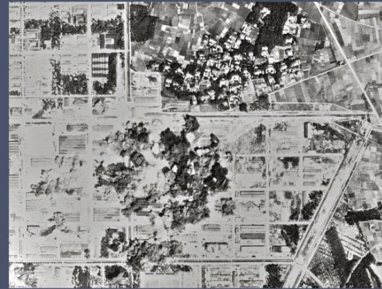
500ポンド爆弾の着弾の状況
