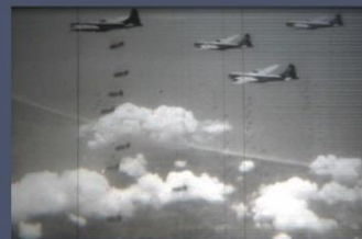
⑧ カメラマン搭乗機の右側を飛ぶB29爆撃機が、爆弾を雨のように投下している様子。遠くに白線のように見えるのは、表浜海岸(遠州灘海岸)。
