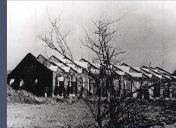
雷管圧搾工場
