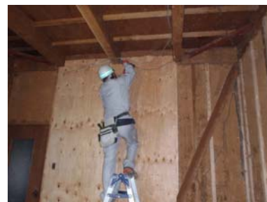
耐震改修の様子
