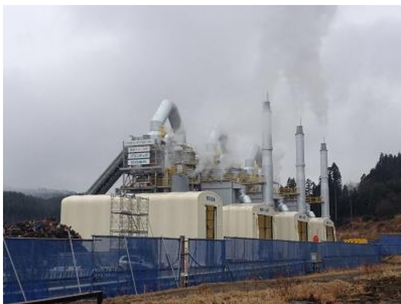
仮設焼却炉の状況
