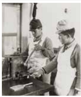
工員による雷管の圧さく作業
