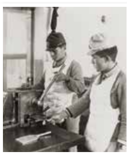
工員による雷管の圧さく作業
