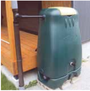
雨水貯留タンク
