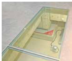
地下に配置された免震装置。防災センター1階の見学窓から見る事ができます。
