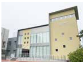
豊川市防災センターの整備
