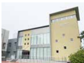
豊川市防災センターの整備
