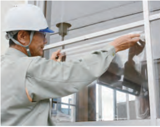
窓ガラス飛散防止フィルム (フィルム費用は約1平方メートルあたり約4000円。1階だけ)
