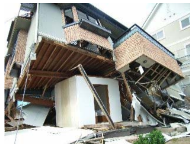
実物大のシェルターによる実験の様子
