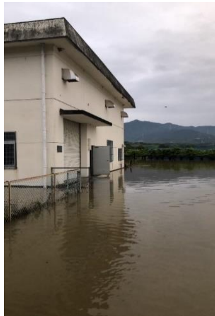
金沢町地内 (下ノ郷排水機場)
