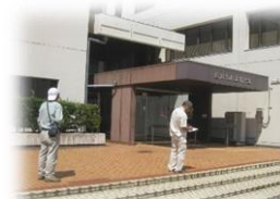
劣化調査の様子
