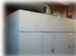
発電機更新工事
