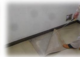
シートのめくれ
