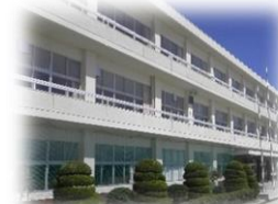
外壁改修工事
