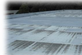
屋上防水改修工事
