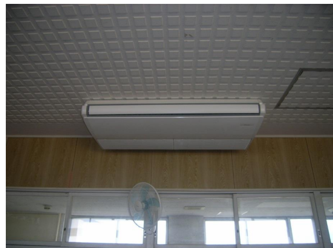
空調設備設置例（天吊型エアコン）
