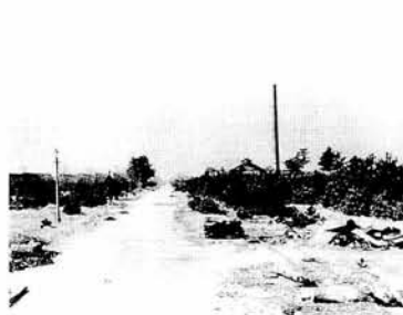
北東門より西方を望む
