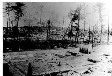
破壊された工場
