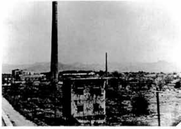
工場中央部から南東方面を望む
