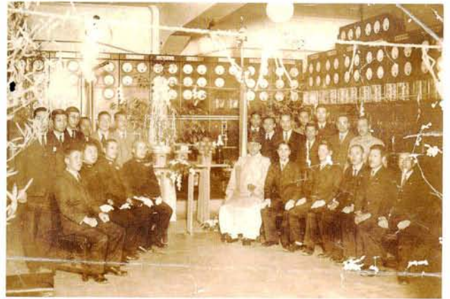
電気工場変電所増設工事竣工記念
