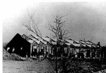
雷管圧搾工場
