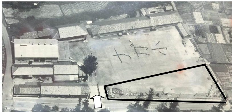
【運動場の拡張（四角い部分）】
