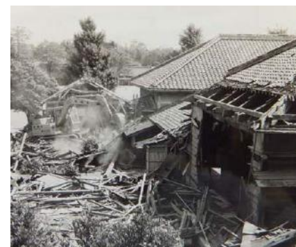
木造校舎取り壊しの様子(S53)
