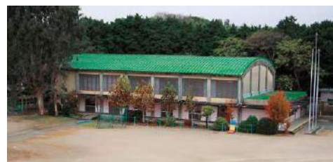
旧体育館 (S43竣工)
