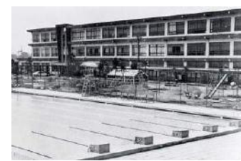
プール完成(S45)
