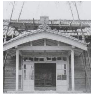
音羽中学校校舎竣工記念写真(S23)
