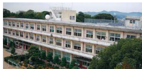
現在の南校舎 (S48竣工)
