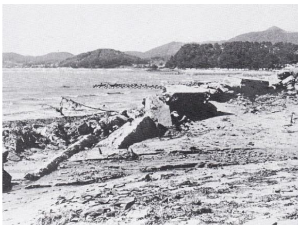
台風 13 号の高潮被害（御津町制五十年写真集より）
