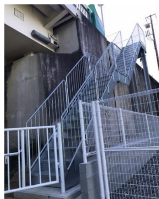
西方大橋へ避難可能な避難用階段
