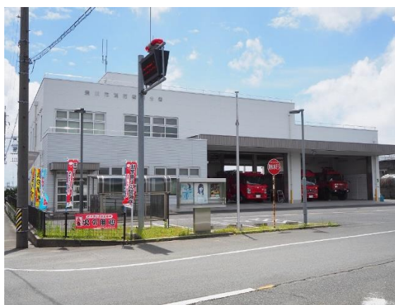
災害対策車を備えた消防署南分署
