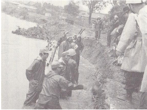
■昭和 38 年 5 月大雨による音羽川の堤防崩落（国府町南田橋西右岸の修復作業写真と現在）
