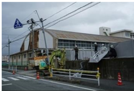
突風で破損した金屋中学校のフェンス
