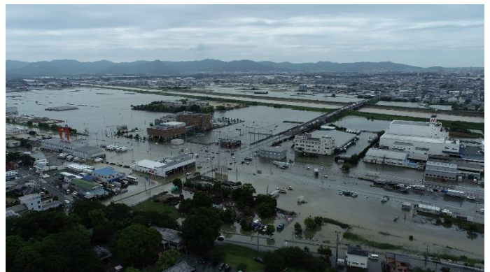
■大雨による冠水状況（小坂井町：R5.6.3朝撮影）
