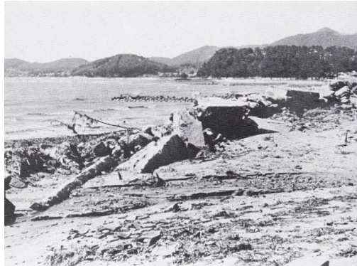
■昭和28年台風13号による高潮被害（御津町大草海岸の大破した堤防と現在の堤防：大草橋付近）
