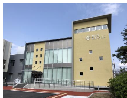
免振装置を備えた豊川市防災センター
