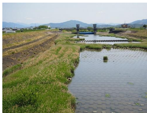
昭和40年に完成した豊川放水路
