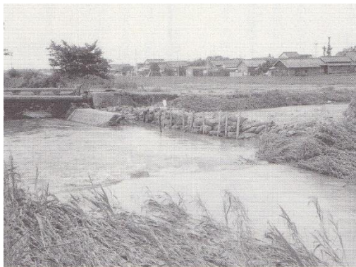
■昭和 49 年七夕豪雨による白川の決壊（市田町出口橋北側右岸の決壊状況と現在：出口橋北）
