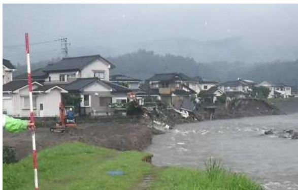
河岸侵食による家屋の倒壊(花月川)
