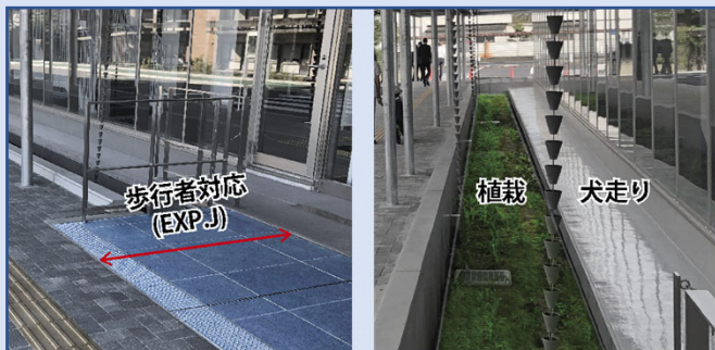
図 5-2. 免震クリアランスとEXP.J金物のイメージ
