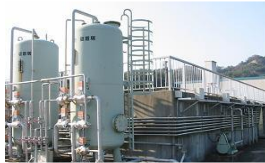
浸出水処理施設
