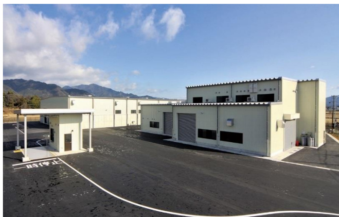
刈草剪定枝破砕堆肥化施設／不燃ごみ・資源選別施設／計量棟
