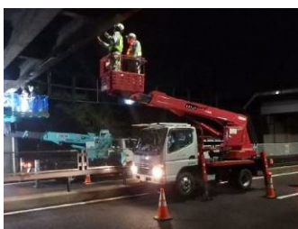
近接目視点検状況：樫王橋 (小坂井町)
