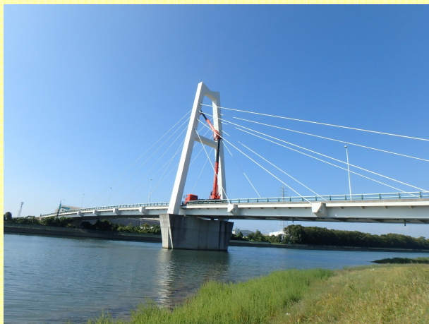
斜張橋の1巡目の点検状況(大型高所作業車)
