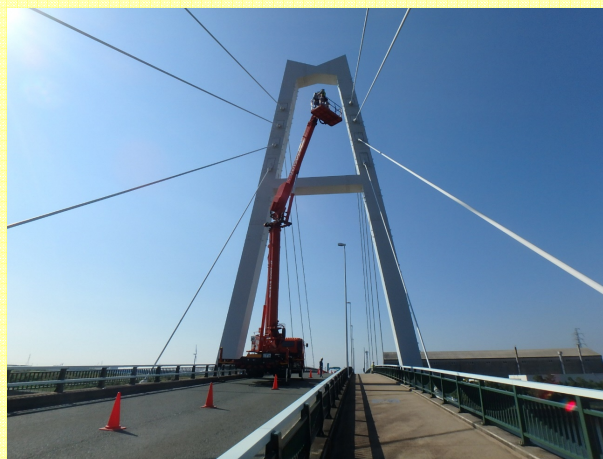
斜張橋の1巡目の車線規制状況
