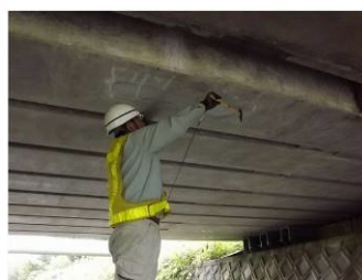
近接目視点検状況：ゲンサウ橋 (菟町)
