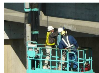
近接目視点検状況：行明橋 (行明町)
