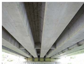
コンクリート橋
