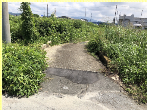
原溝1号橋（撤去予定）
