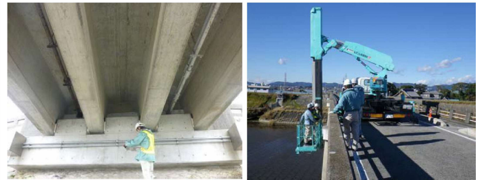
写真：専門業者による点検状況
