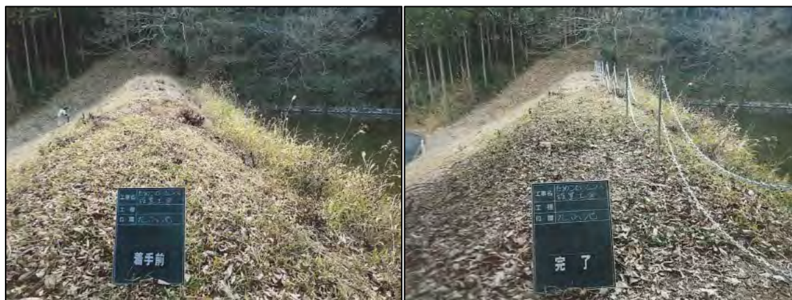
参考_ため池フェンス設置前後
