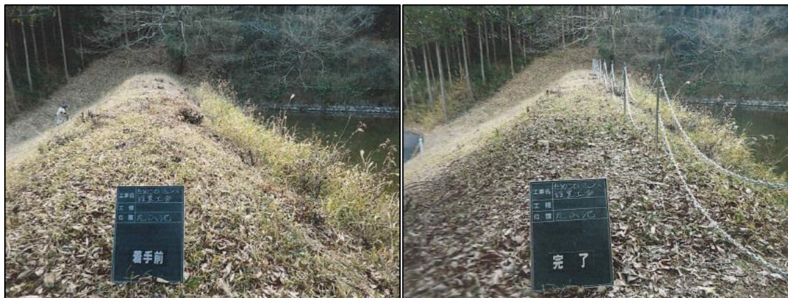
参考_ため池フェンス設置前後
