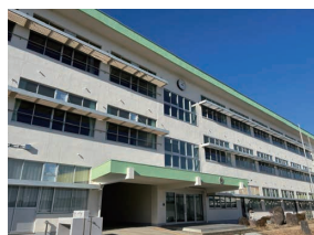
三蔵子小学校の改修
