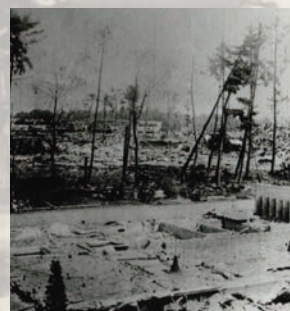
破壊された工場
