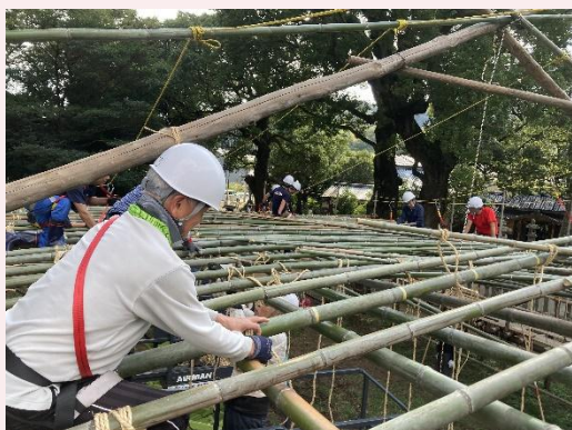
小屋掛け作業風景
