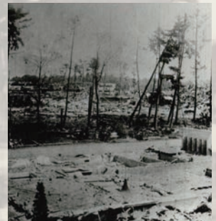
破壊された工場
