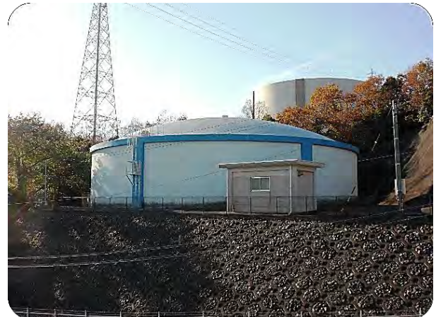
ひらおだいいちはいすいち 平尾第1配水池（平尾町）
