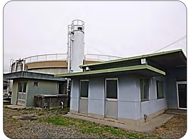
こさかいはいすいじょう 小坂井配水場（小坂井町）
