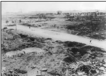
空襲を受け破壊された工廠
