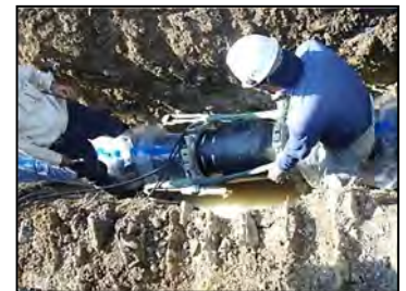
耐震管の布設
