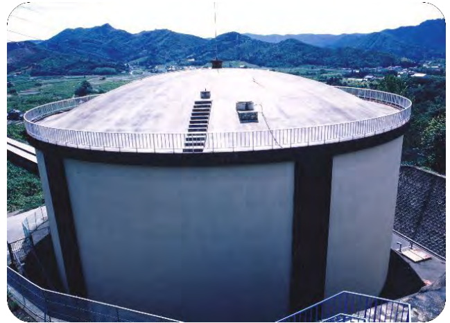
ごんげんはいすいち 権現配水池（三上町）
