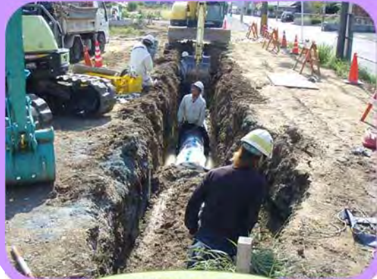
水道管の工事
