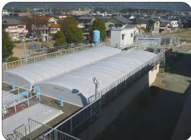
いちのみやしじょうすいじょう 一宮浄水場（一宮町）
