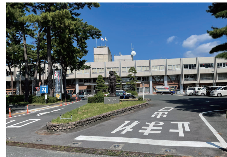
A : 敷地南側より望む 既存本庁舎
