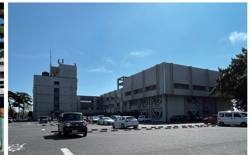
B : 敷地北西から望む 既存本庁舎と北庁舎
