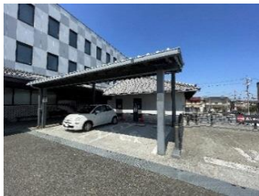
屋根付き駐車場(高浜市)
