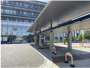
屋根付き通路(半田市)
