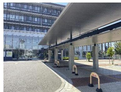
屋根付き通路(半田市)
