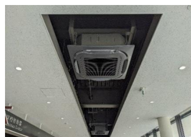
空調設備のメンテナンススペースに配慮した天井(常滑市)
