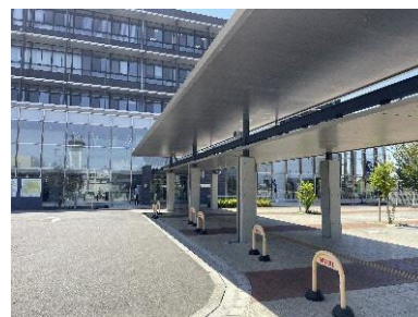
屋根付き通路(半田市)
