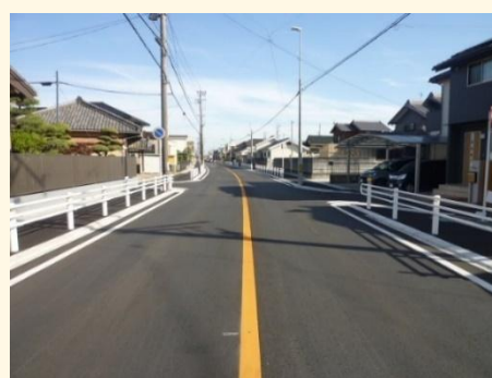
市道城跡市役所線（道路改良工事）
