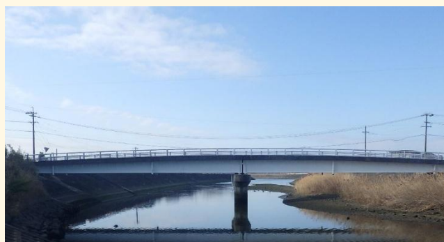
御所橋（橋梁補修工事）
