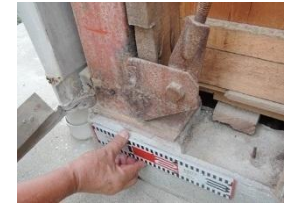
鉄骨腐食度調査（小さな錆）
