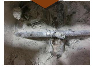
鉄筋の腐食度調査（腐食無）
