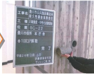
採取したコンクリート（コア）について圧縮強度試験・中性化試験を実施
