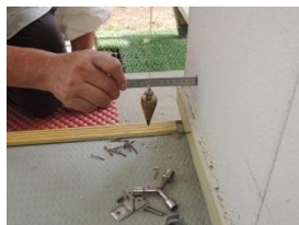
柱の傾斜調査
