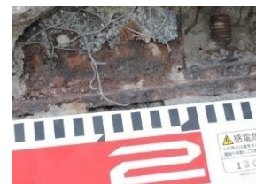
鉄骨腐食度調査
