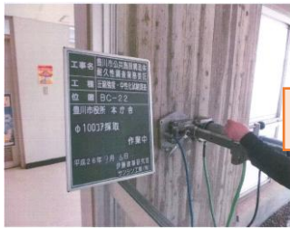
コンクリート壁のコア抜き
