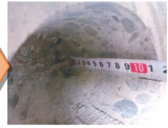
コンクリート内の鉄筋について被り寸法・腐食度調査を実施
