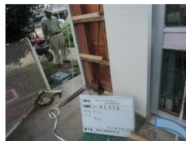
壁を取り外して調査
