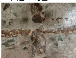
鉄筋の腐食調査
