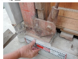
鉄骨腐食度調査
