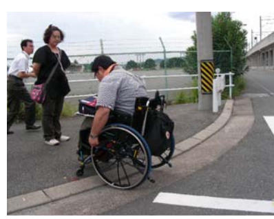
《交差点部の段差》
