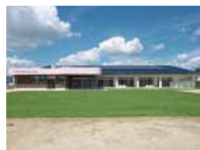
小坂井東保育園の改築
